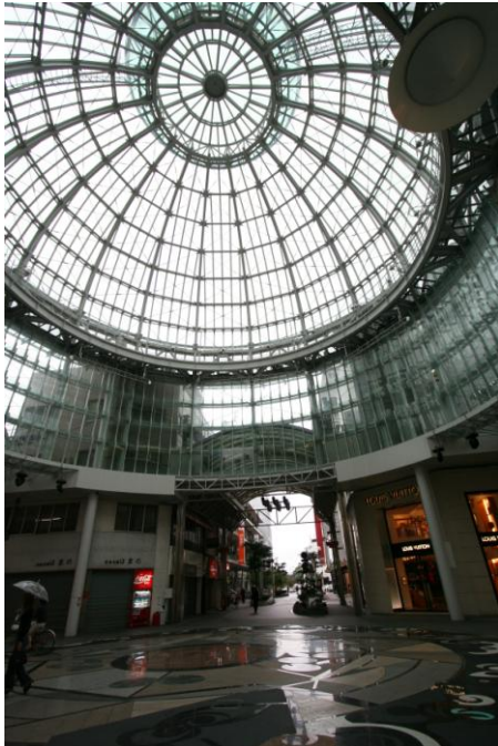
完成した丸亀町商店街・壱番街のドーム
